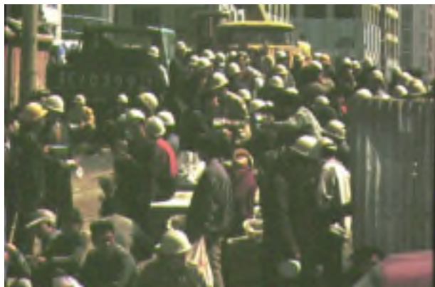
Großbaustellen gehören zum Alltagsbild
